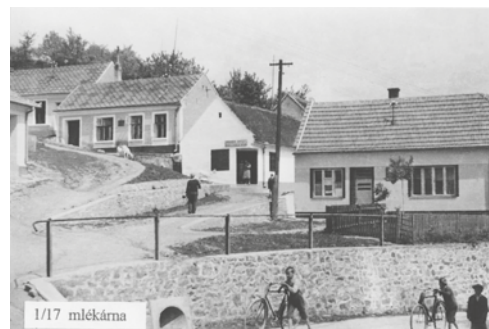
Číslo popisné 24 – bývalá mlékárna
