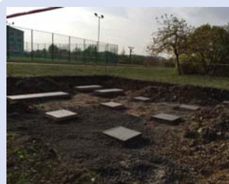
Příprava základů pro workoutové hřiště u Základní školy
