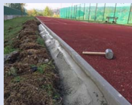
Oprava obrub u tartanové dráhy
