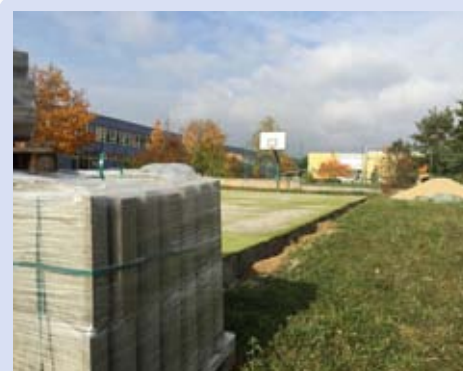
Demontovaný umělý trávník jsme ještě použili na basketbalové hřiště a budujeme nové odvodnění
