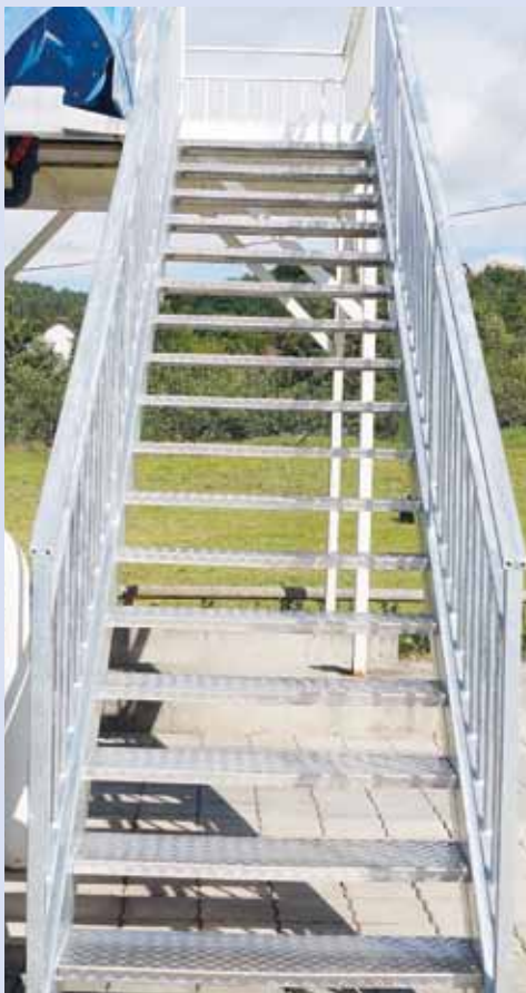
Nové schody a přístřešek na koupališti
