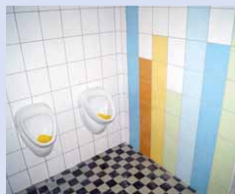
Rekonstrukce toalet ZŠ
