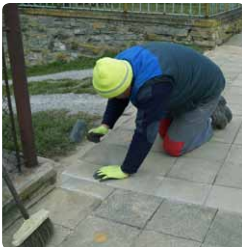
Práce na novém chodníku
