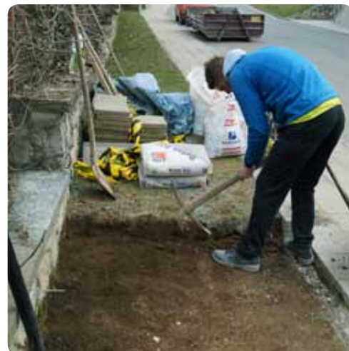
Práce na novém chodníku
