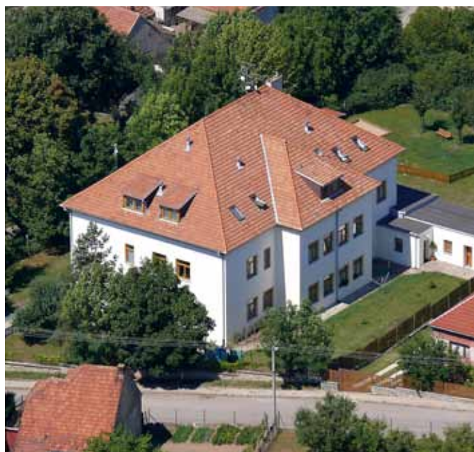
Letecký snímek dnešní podoby budovy
