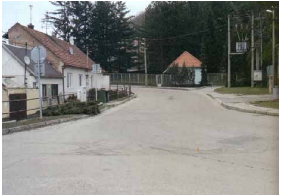
Náves obce Mokrá – současný stav (2008) uprostřed je čerpací stanice
